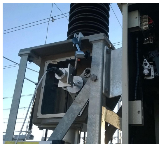
图 2：安装于 ABB LTB 245 kV SF6 断路器上的数字旋转传感器
